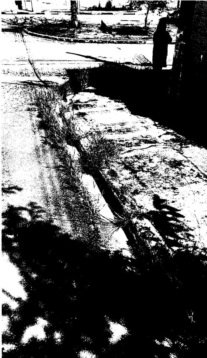
CAPINAÇÃO DE CABEÇAS DE GUIAS E RASPAGEM DE SARJETAS EM TODA A EXTENSÃO DA RUA BENEDICTO PINHAL COM A RUA VANDI ROCHA, VILA NOVA CINTRA – MOGI DAS CRUZES.
